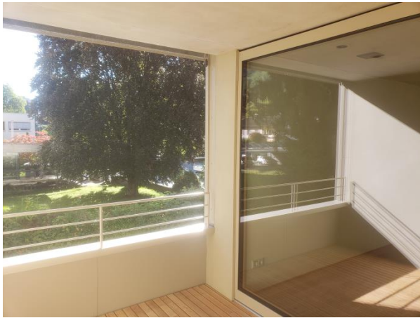
Loggia mit Screen an der Außenseite
