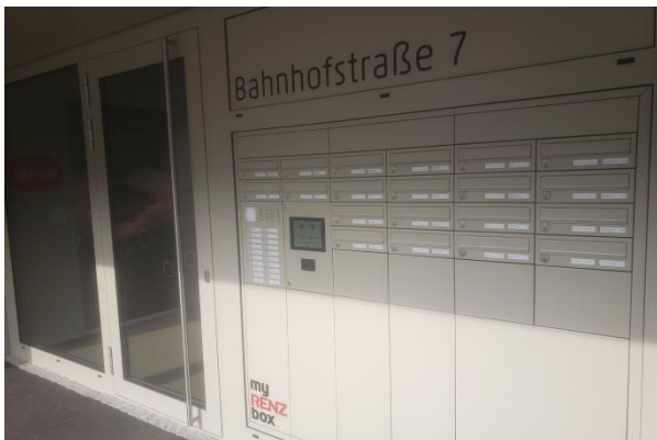
Eingangsbereich mit elektronischer Paketbox
