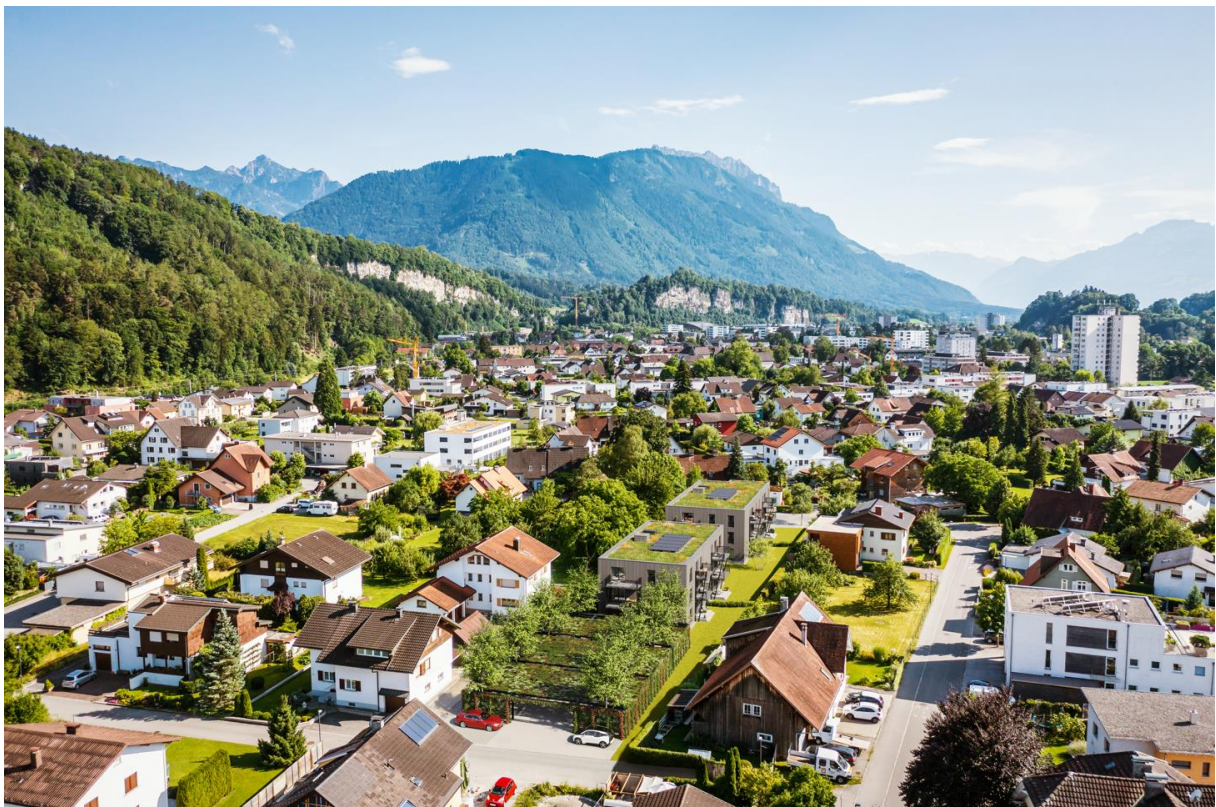
AUTOUNTERSTELLPLÄTZE CARPORT AN DER TANNENGASSE DANACH FOLGT HAUS 2, DAHINTER HAUS 1
