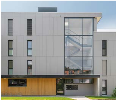
Wohnanlage Apfelgasse 1 + 1a | Schwarzach
