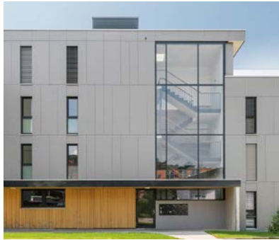
Wohnanlage Apfelgasse 1 + 1a | Schwarzach
