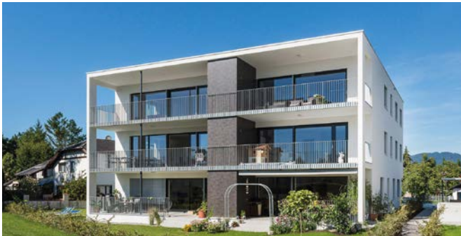
Wohnanlage Wieden 41 | Dornbirn
