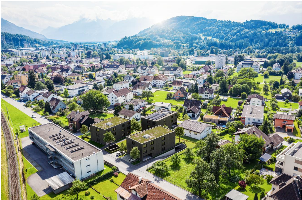
Haus A vorne, Haus B hinten rechts, Haus C hinten links
