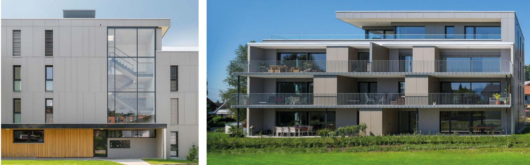
Wohnanlage Apfelgasse 1 + 1a | Schwarzach
