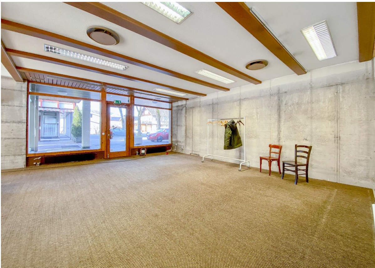
Zugang Nord - Sichtbetonwand
