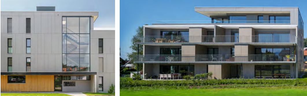
Wohnanlage Apfelgasse 1 + 1a | Schwarzach
