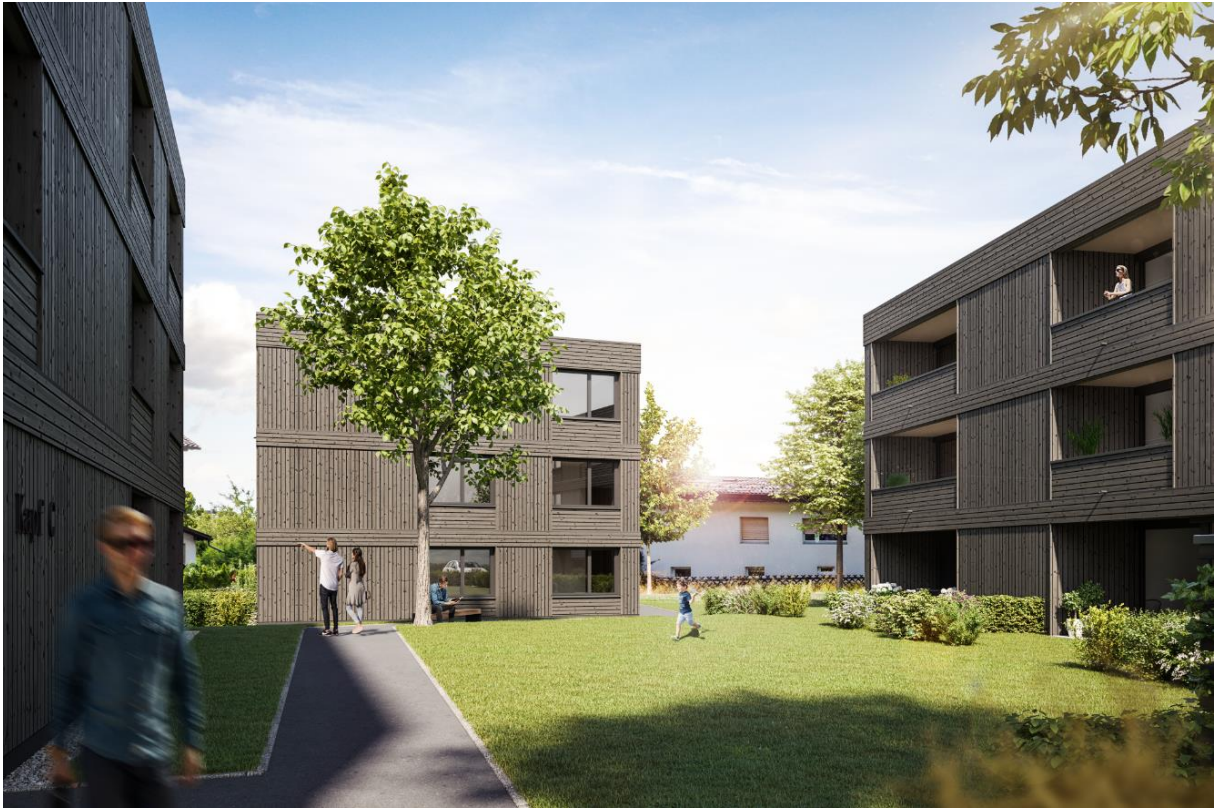
Haus A rechts, Haus B hinten , Haus C links
