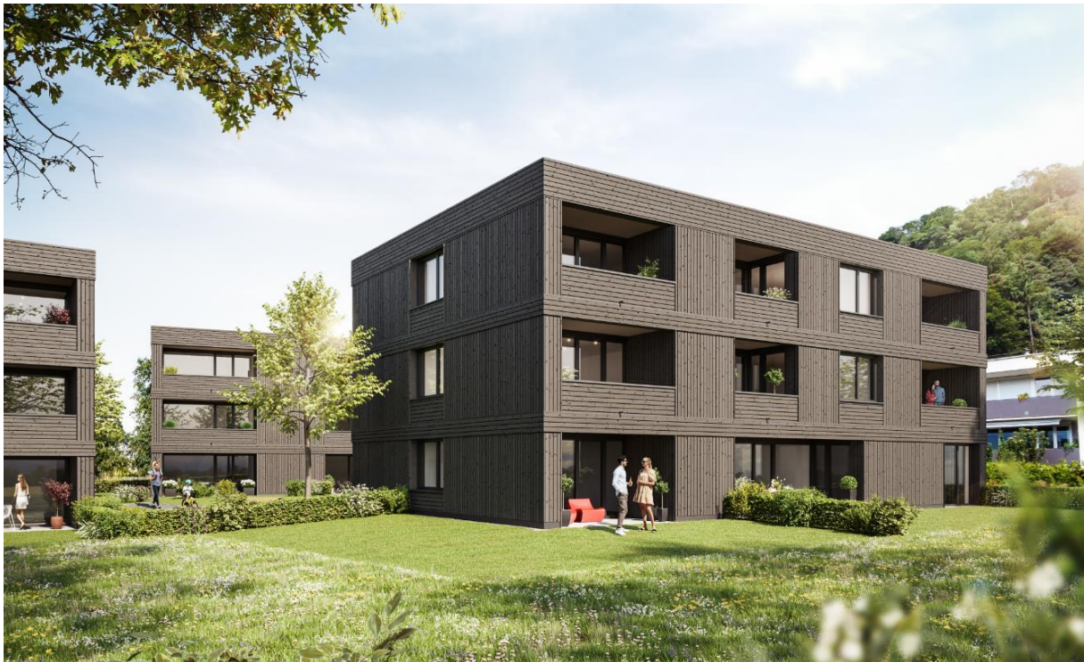
Haus A ganz hinten, Haus B links, Haus C rechts vorne
