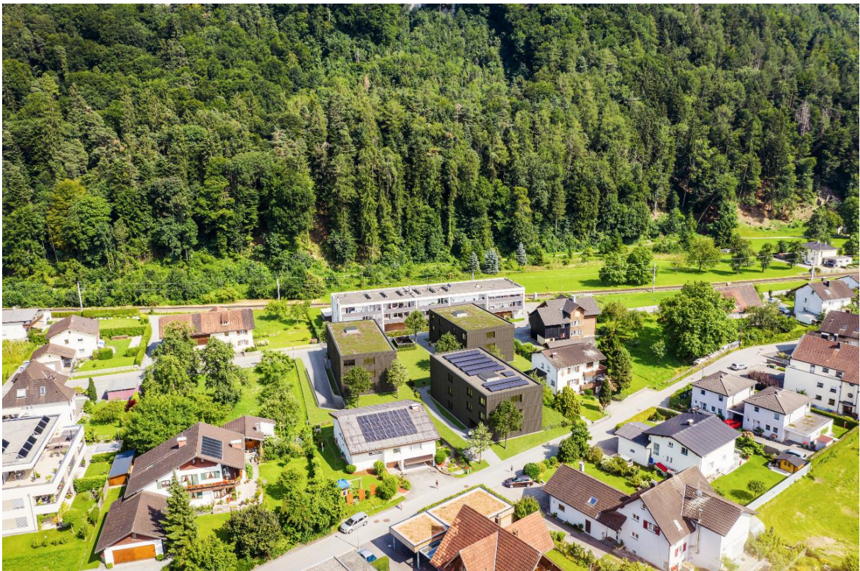
Haus A links hinten, Haus B vorne, Haus C hinten rechts
