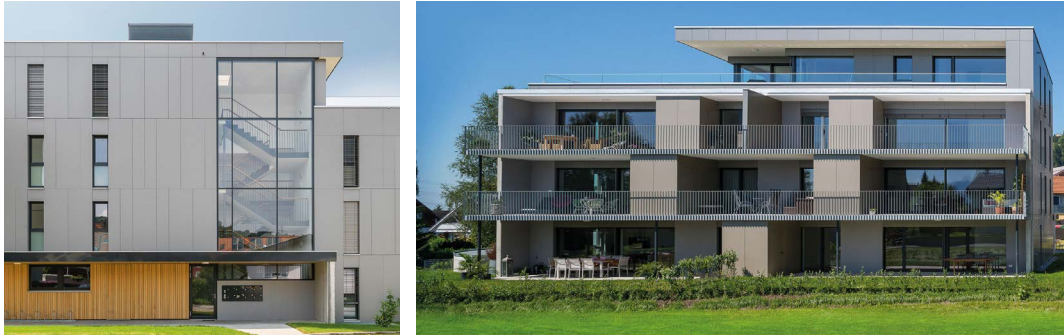
Wohnanlage Apfelgasse 1 + 1a | Schwarzach
