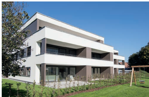
Wohnanlage Weiherstraße, Lustenau
