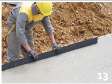
Fugenband zur Abdichtung zwischen Fundamentplatte und Wand
