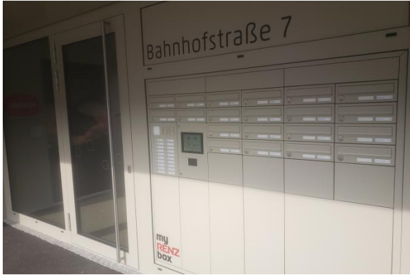
Eingangsbereich mit elektronischer Paketbox
