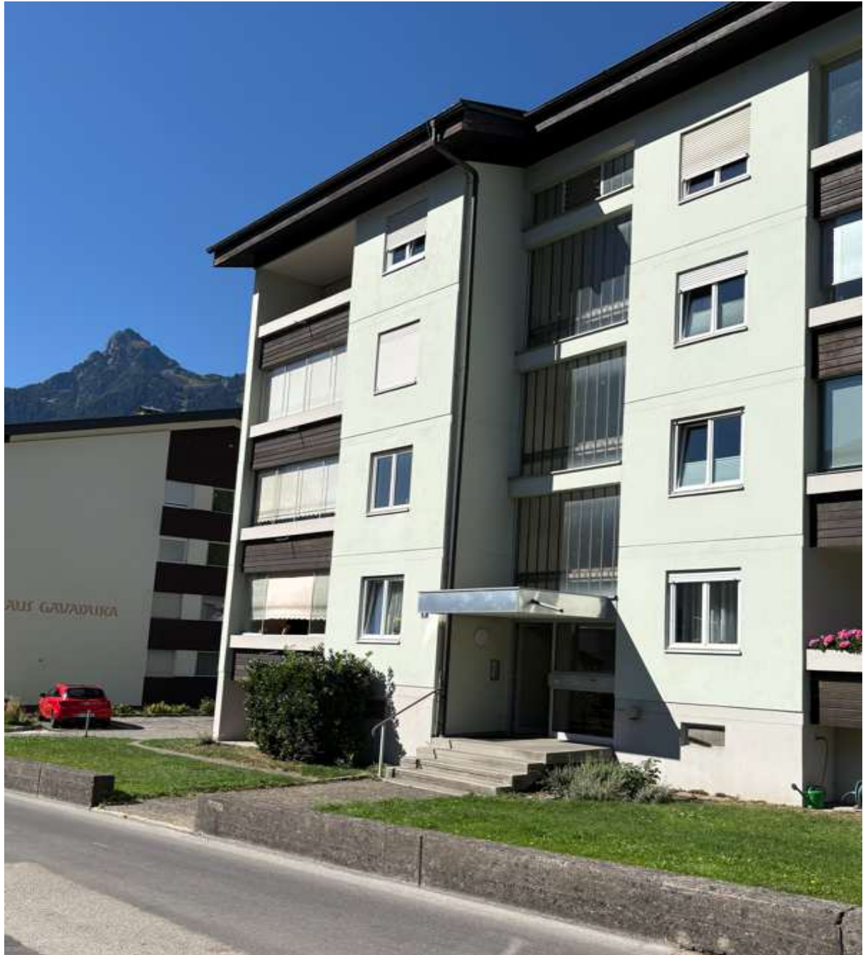
Hausansicht / Eingang Wagnerweg 6
