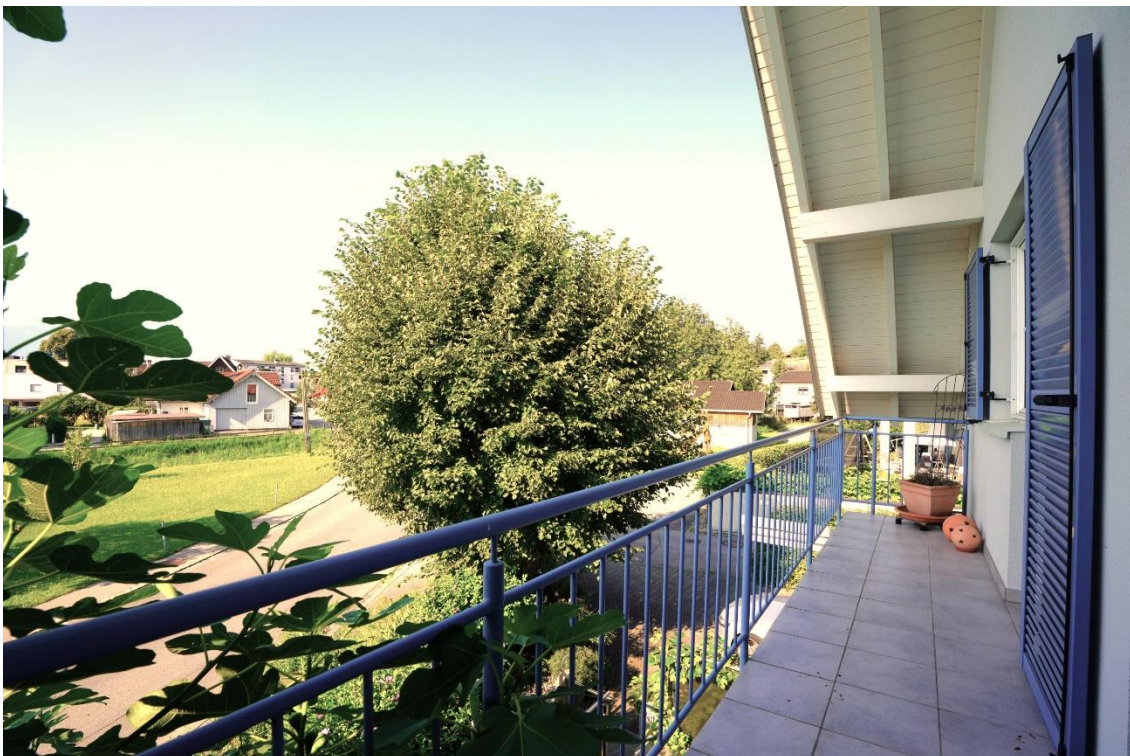
Balkon im Obergeschoss
