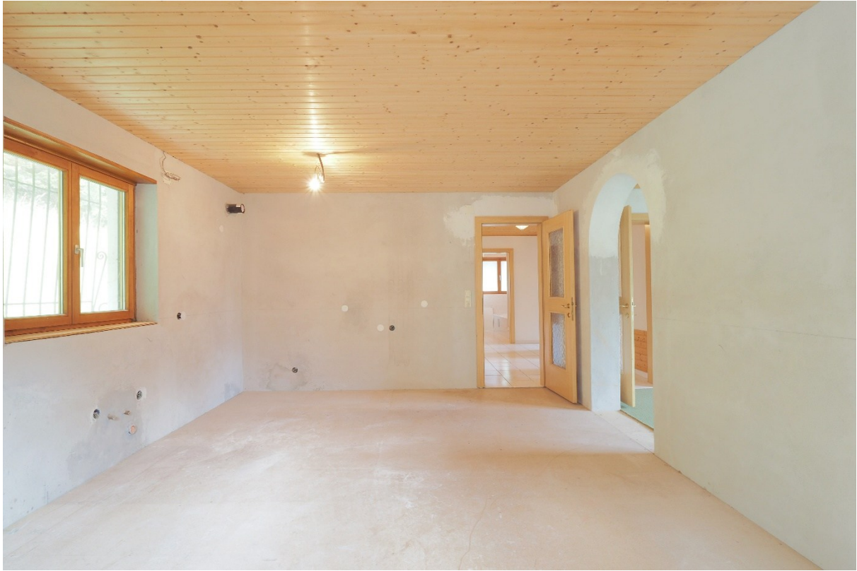
Küche OG (Rohbau, für den Wunschausbau vorbereitet)
