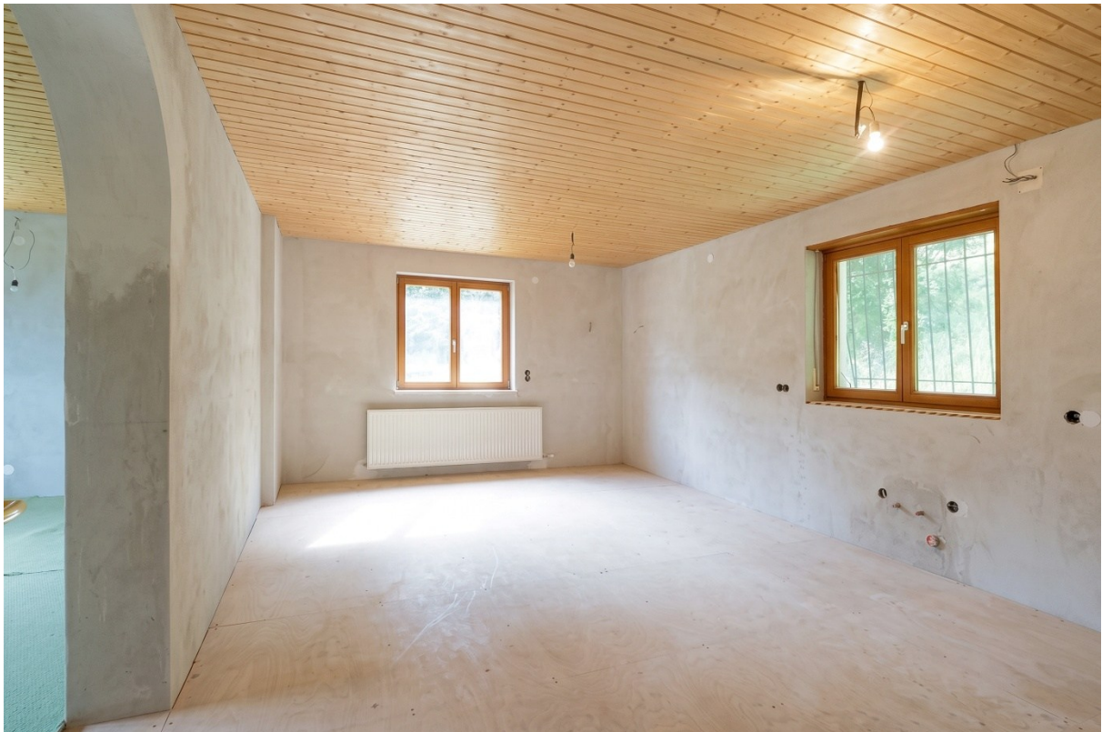
Küche OG (Rohbau, für den Wunschausbau vorbereitet)
