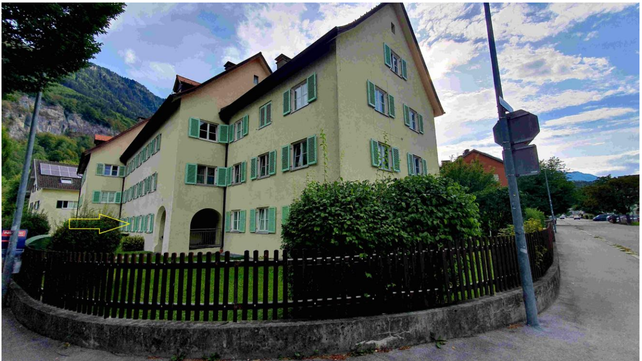
Außenansicht Wohnung im Erdgeschoss
