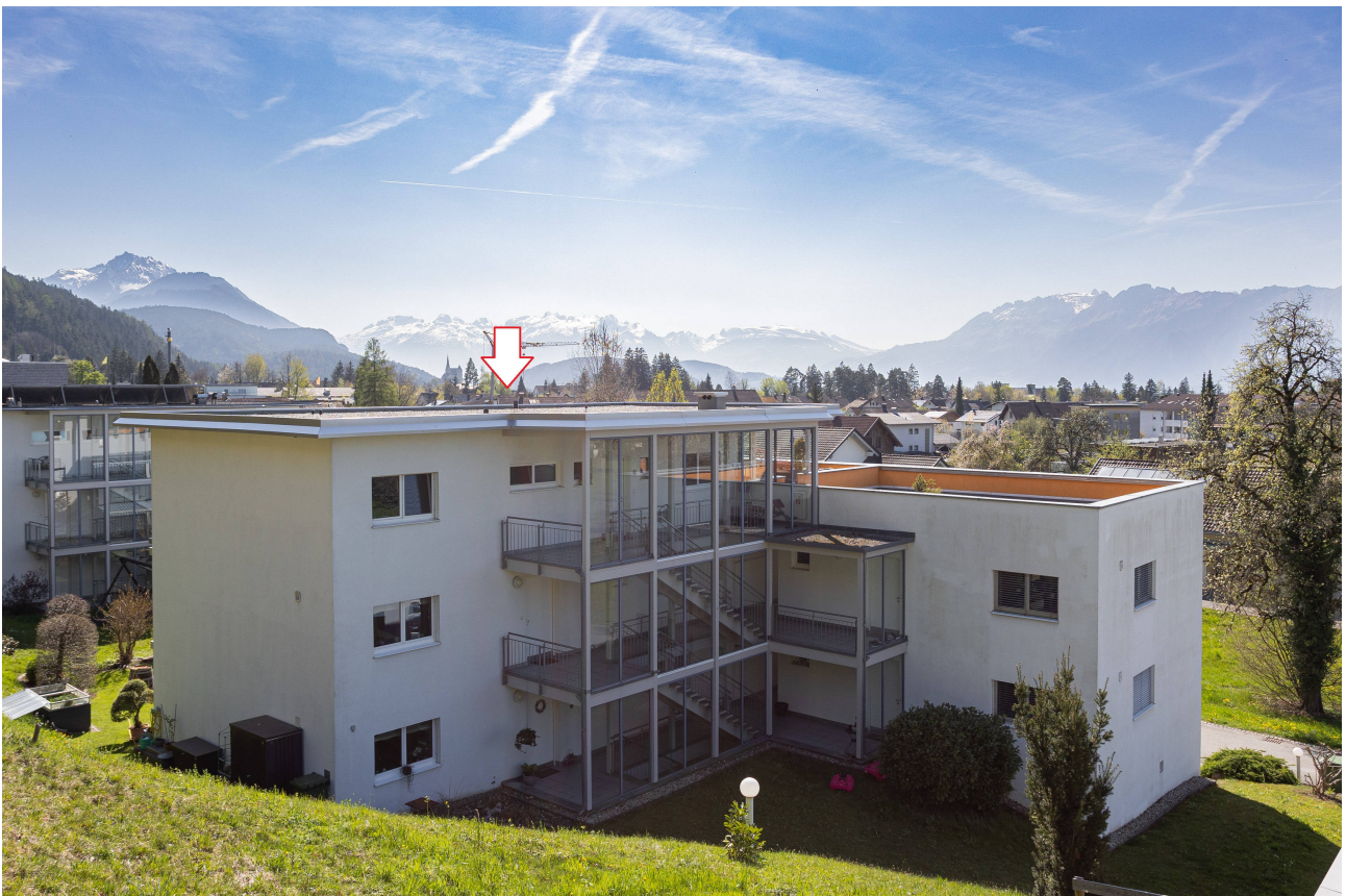
Außenansicht mit Blick nach Süd-West
