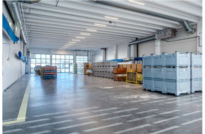
INDUSTRIEHALLE MIT BLICK NACH NORDEN
