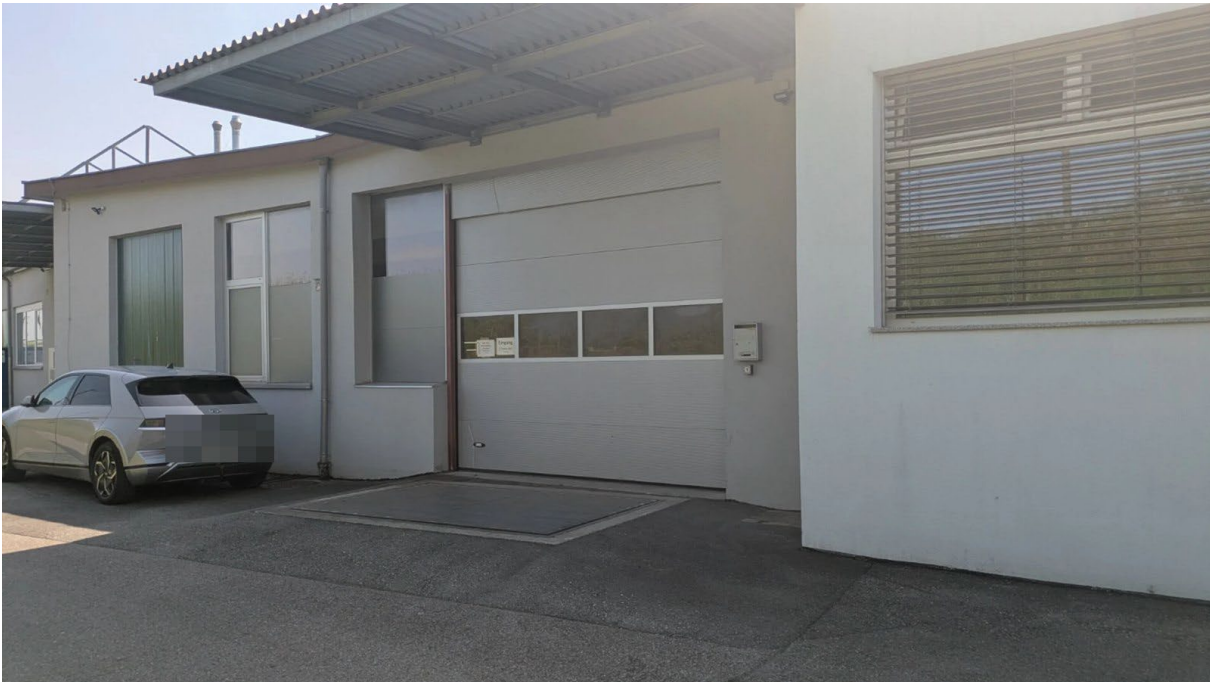
Außenansicht: Andienung mit Sektionaltor, Hubtisch und separatem Besuchereingang, Augartenstraße 27
