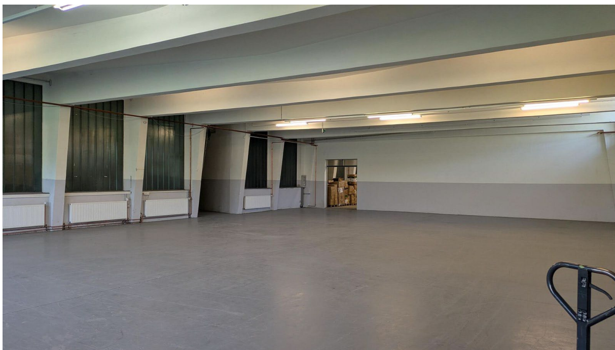
Haupthalle Vorderbereich: Innenraum mit Fensterelementen
