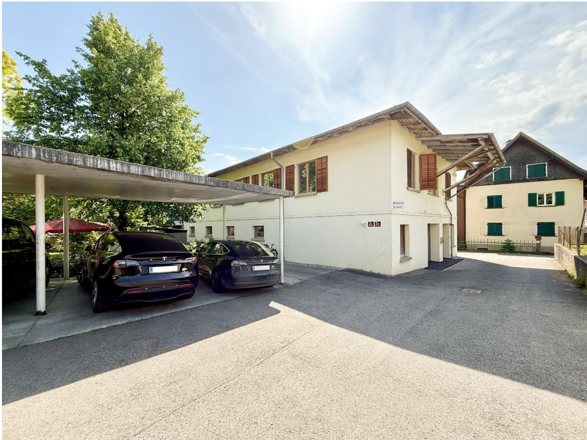
Ansicht Nord-Ost mit zwei Carports
