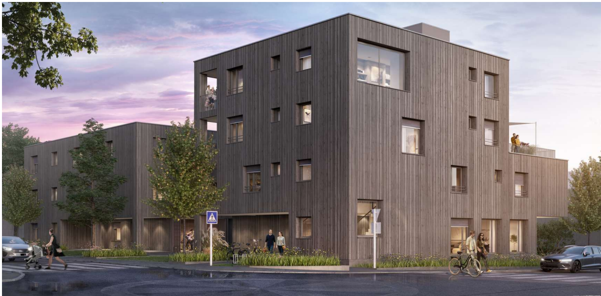
Haus B links, Haus A rechts, Ecke Hadeldorfstraße/Landammanngasse
