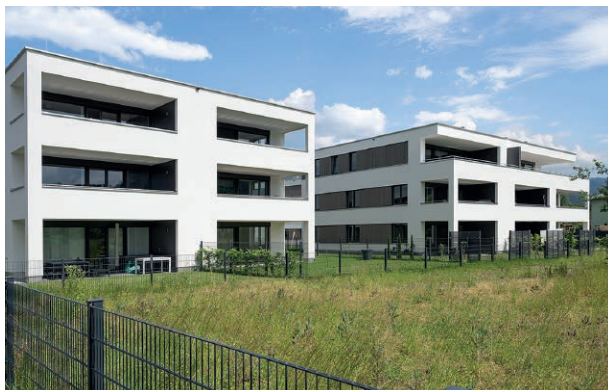
Wohnanlage Baumgarten, Mäder
