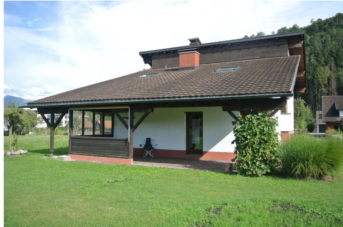
Überdachter Sitzplatz, Westseite
