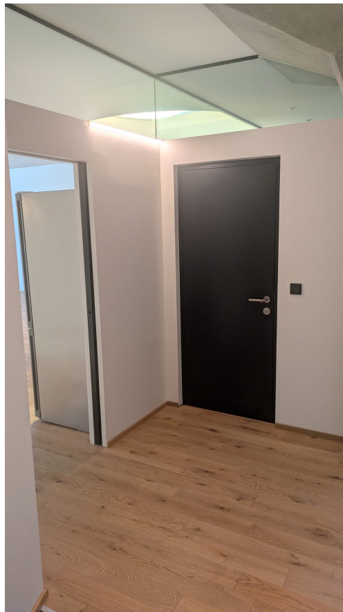
Vorraum mit Glasabschluss, Lichtvoute und Schiebetür in der Wandtasche
