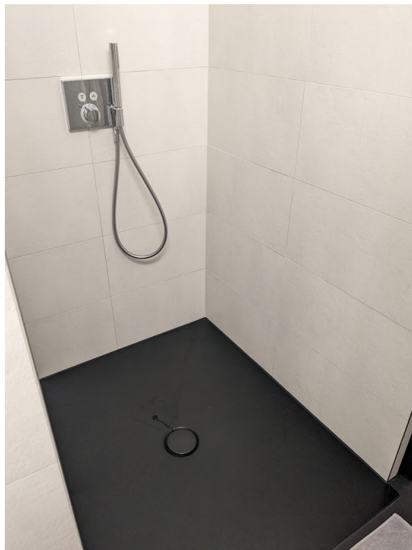
Bodenebene Walk-in-Dusche mit Unterputz-Thermostat
