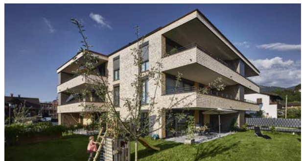
Wohnanlage Sonnengasse | Dornbirn
