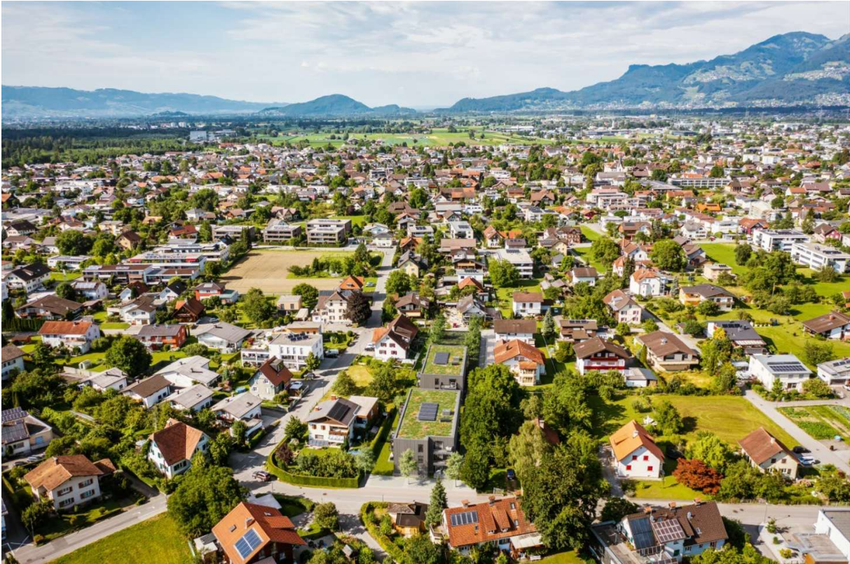
VORNE HAUS 1 IN DER MARIENSTRASSE, HINTEN HAUS 2
