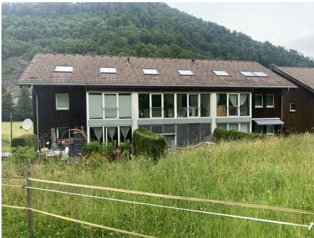
Ansicht Südosten (Aufnahme 20.06.2024)
