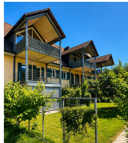
Die Südfassade des Hauses
