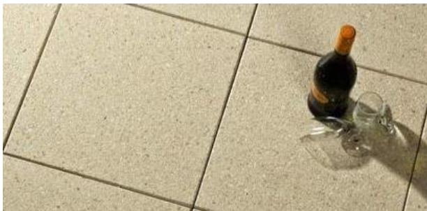
Beispiel für einen Beton-Plattenbelag (Symbolbild)
