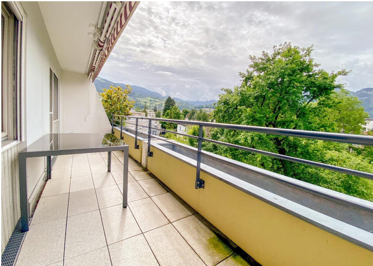
Balkon im Dachgeschoß
