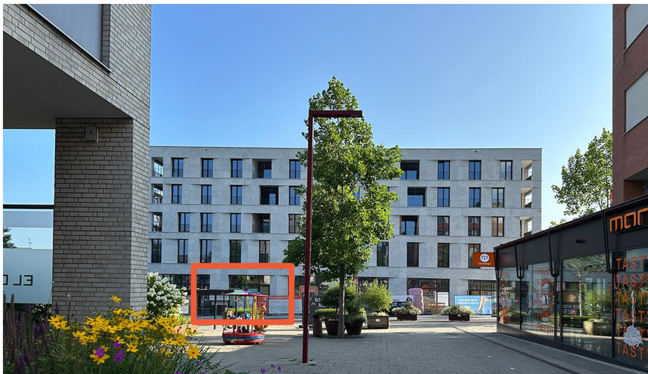
Ansicht Gebäude / Mietfläche EG
